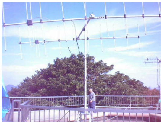
屋上に設置された移動アンテナV/U
